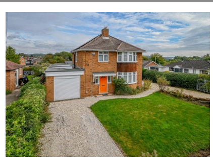
23 Conduit Lane, Bridgnorth
