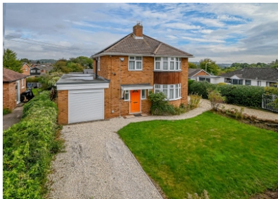
23 Conduit Lane, Bridgnorth
